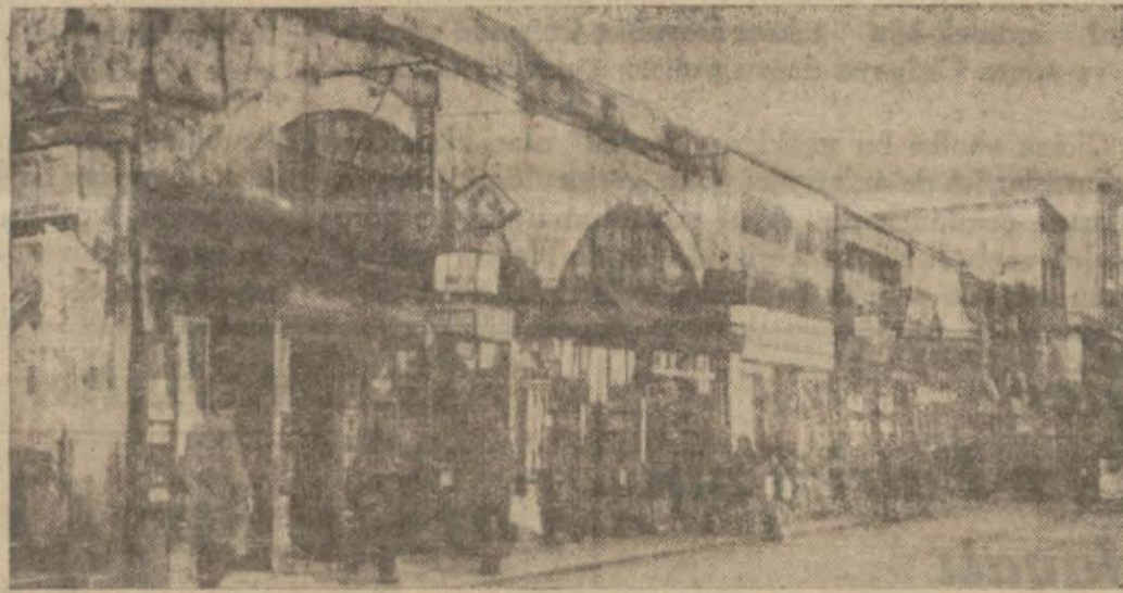
Ticaret sarayının yapılması düşünülen yer burasıdır
